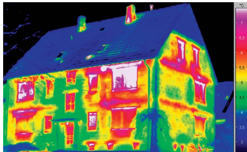
Quelle: Die Energieberater, Oberhausen
